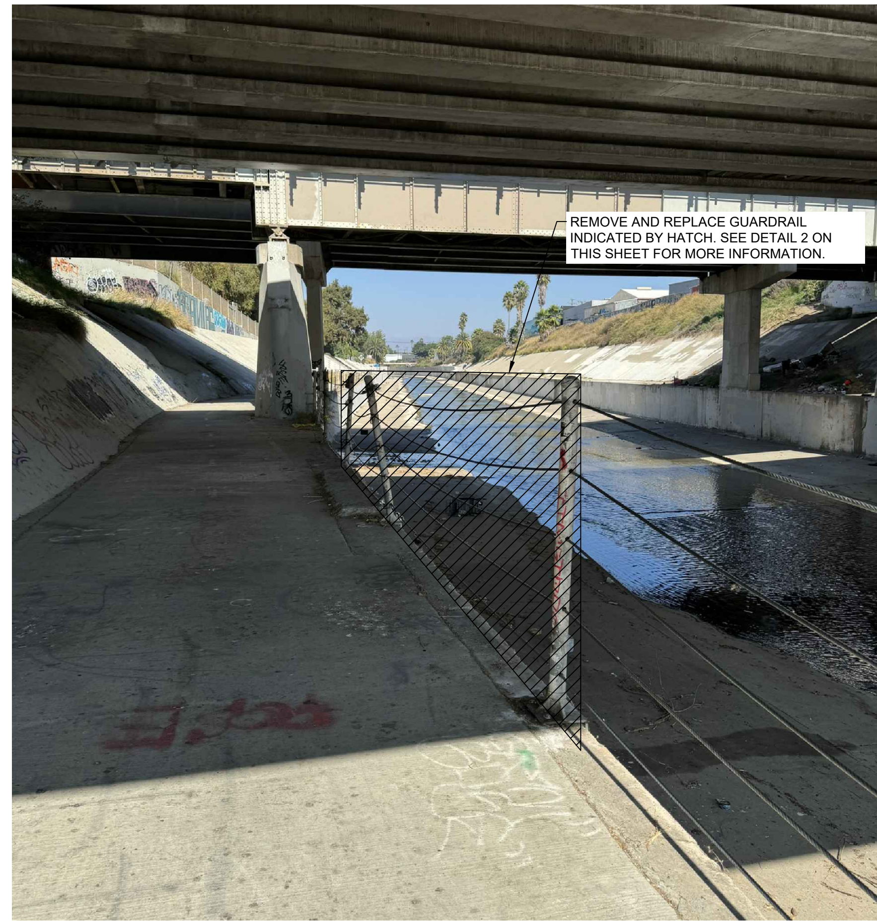
1 EXISTING GUARDRAIL PHOTOGRAPH SCALE: N.T.S.
